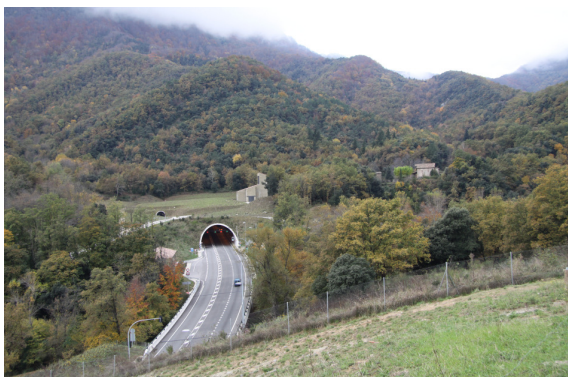
Figura 2.- Embocadura del túnel de Bracons a la Vall de Joanetes el 13 de novembre de 2011. Autor: Emili Bassols.
